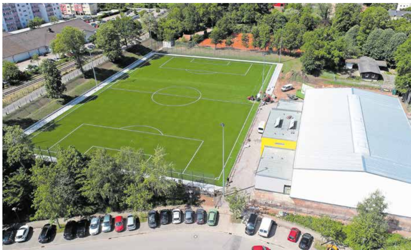
Der Blick von oben auf den neuen Platz beim Verlegen des Kunstrasens.
