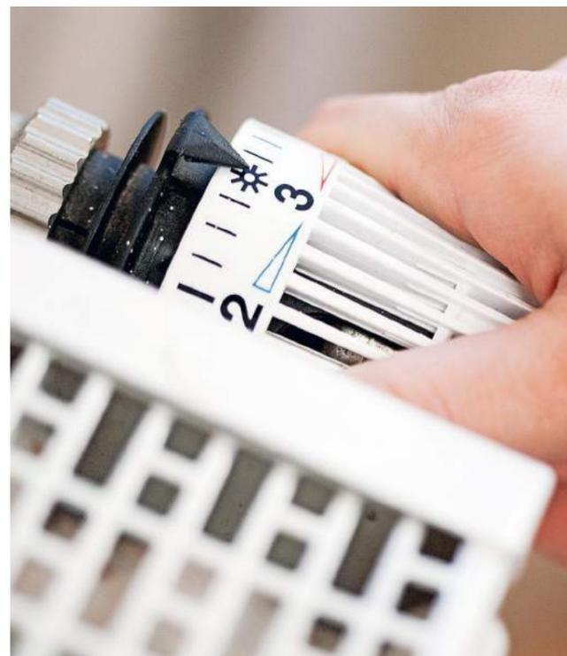
Ein hydraulischer Abgleich hilft dabei, dass in jedem Heizkörper des Hauses ausreichend Wärme ankommt - und man das Ventil nicht zu hoch drehen muss
