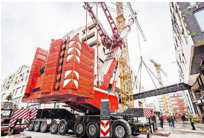
Einbau des Fußgängerstegs in Q 6/Q 7.
