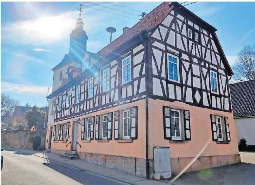
Das Dorfgemeinschaftshaus erhält Photovoltaikanlage und Wärmepumpe
