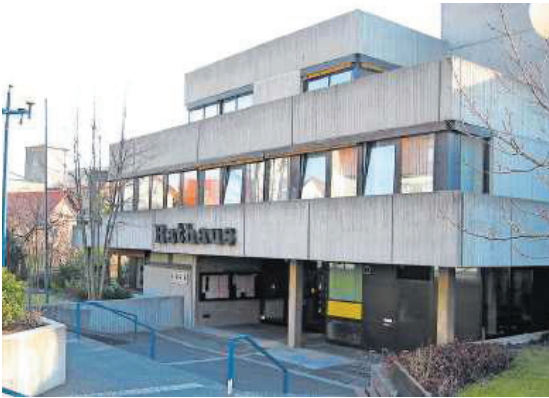
Das Rathaus vor den Sanierungen
