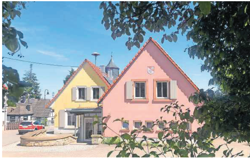
Das Dorfgemeinschaftshaus in Bennhausen nach dem Umbau
