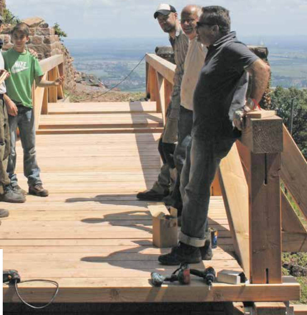
Kleine Pause zwischen der Arbeit an der Brücke.
