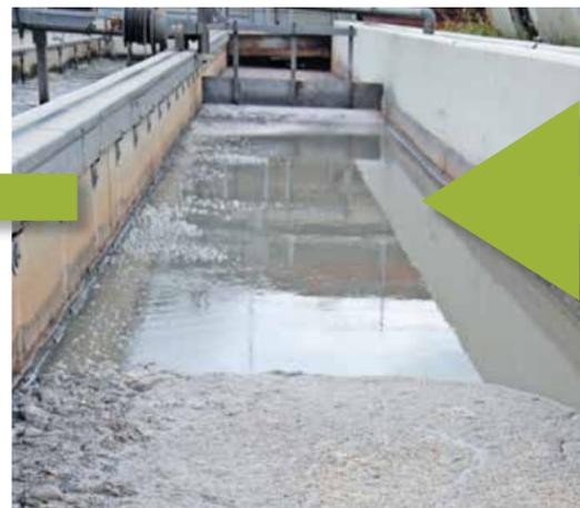
Der Sand- und Fettfang reinigt das Wasser von Sand und Fett. Durch eine grobblasige Belüftung entsteht eine Walzenströmung im Sandfang. Das Fett wird mitgerissen und strömt in das Fettfangbecken, wo es sich an der Wasseroberfläche sammelt, abgeschöpft und entsorgt wird. „Fett ist problematisch, weil es die nächste biologische Reinigungsstufe belastet, an den Rohrwandungen hängen bleibt und irgendwann zu Verstopfungen führt“, so Raisin.
