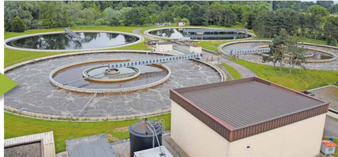
Aus den Belebungsbecken (vorne im Bild) fließt das Wasser in die Nachklärbecken (hinten), wo nur noch die Schlammflocke vom gereinigten Abwasser getrennt werden muss. Es ist im Winter auch Anlaufstelle für Zugvögel, weil das Wasser wärmer ist als in der Natur. Vom Nachklärbecken fließt das gereinigte Abwasser in die Queich. Einige Stoffe kann die Kläranlage aber nicht reinigen, etwa Hormone, Antibiotika oder
